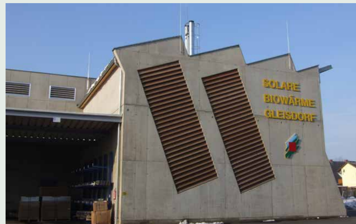
Fotos: Stadtwerke Gleisdorf, Ing. Karl Hierzer
